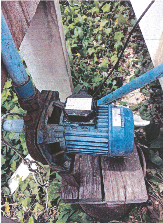
ภาพถ่ายเครื่องสูบน้ำแบบหอยโข่ง (ชำรุดเสียหาย)
